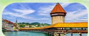
สะพานไมซ์าเปลา
