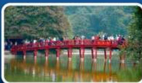
สะพานแสงอาทิตย์
